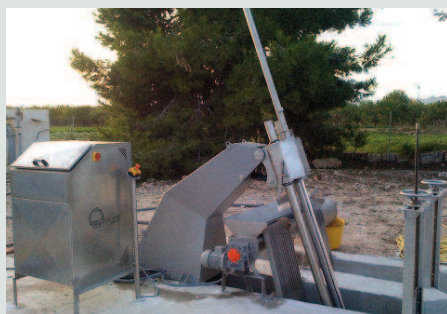
Equipo de accionamiento hidráulico para limpieza y desbaste de canales con transporte y deshidratación
